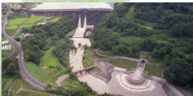
▲洪水調節中の美和ダム（平成18年 7月）
