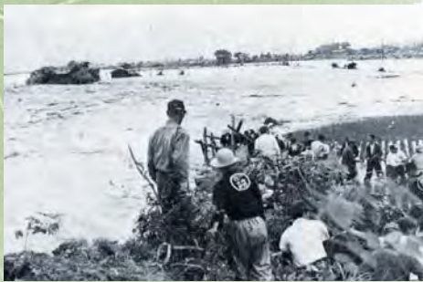
●昭和36年 美簗地区破堤状況
