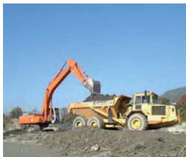
堆砂掘削の状況
