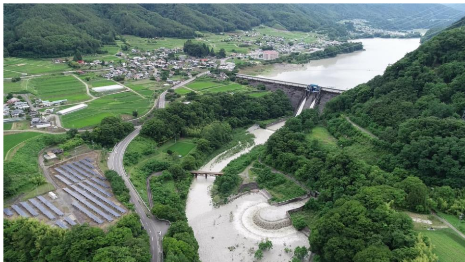
バイパストンネル吐口
