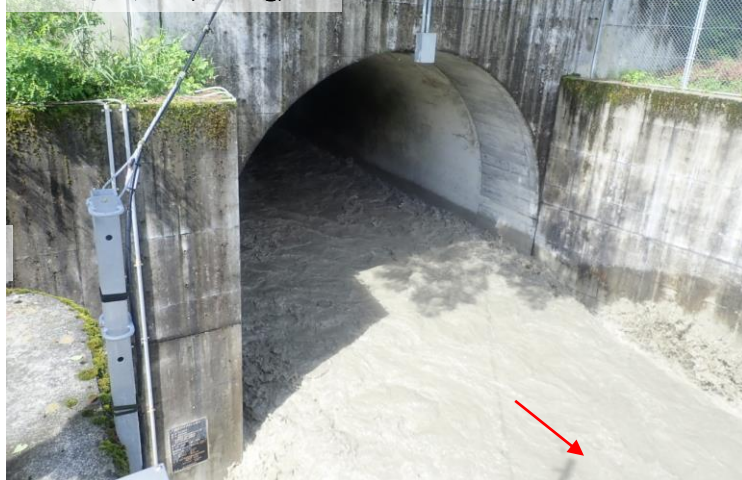
土砂バイパス吐口 3日9時42分 3,700mg/l
