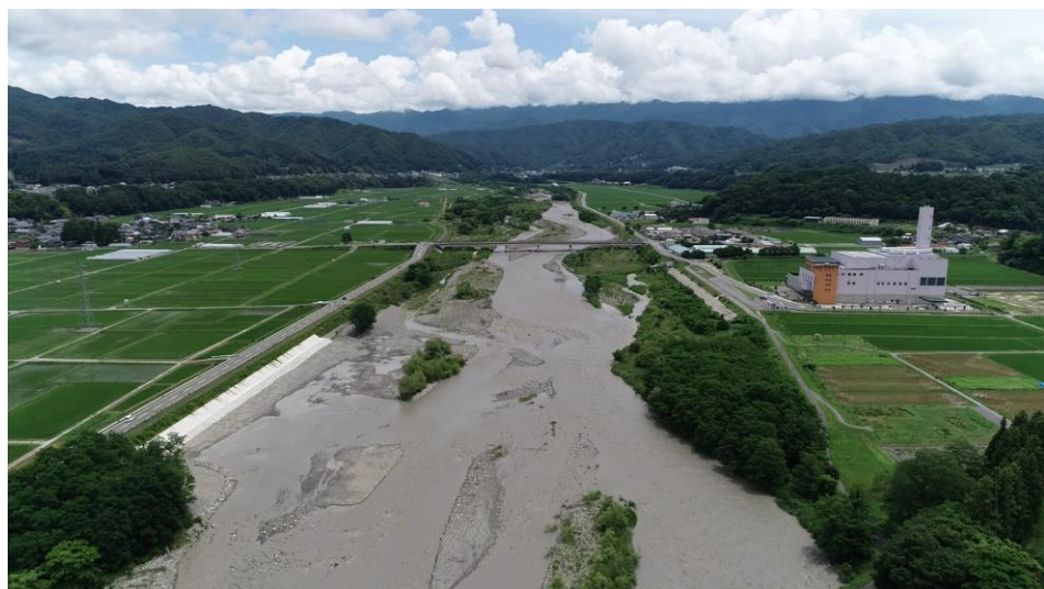
三峰川橋下流
