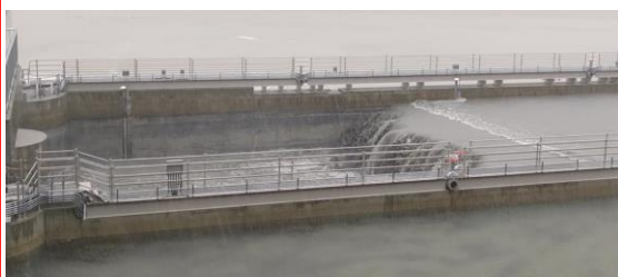
取水ゲート開操作後の水位上昇による越水(14:15:35)
