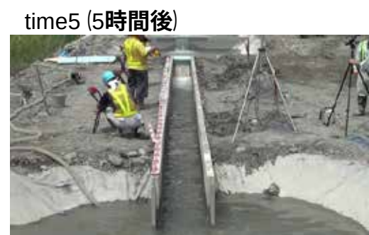
流水力による河床洗掘が進行③
