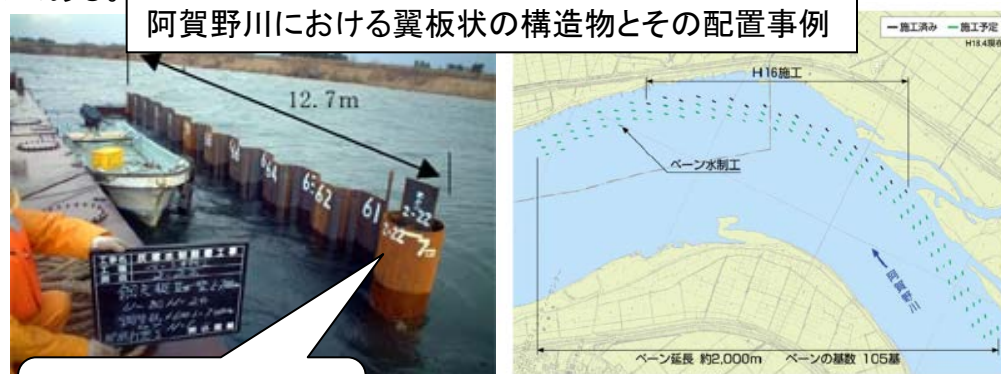
翼板状構造物を鋼矢板で設置した事例
