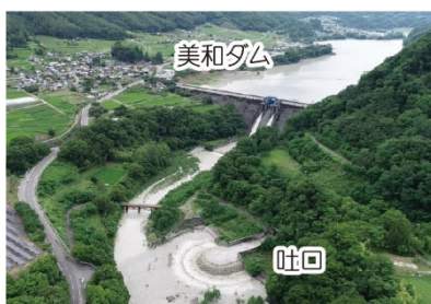
美和ダムと 土砂バイパストンネル吐口
