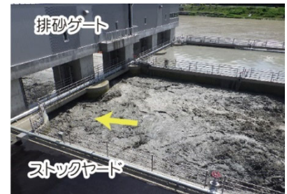
排砂ゲートからの土砂の排出
