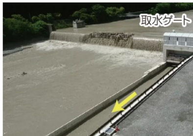
取水ゲートから導水
