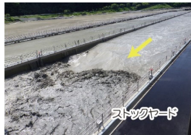
ストックヤード内の様子
