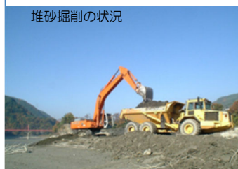
堆砂掘削の状況
