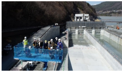
●高所作業車から施設全景を見学
