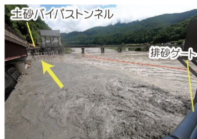
土砂バイパストンネルへ
