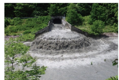
土砂バイパストンネル吐口
