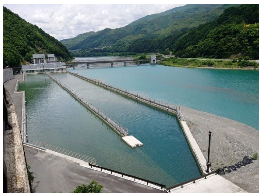
ストックヤード施設全景
