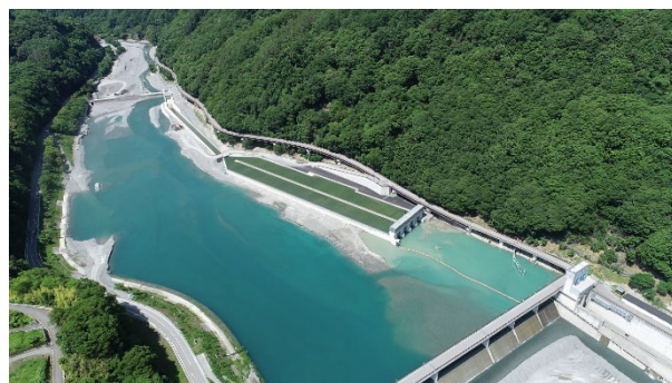
ストックヤード施設と分派堰
