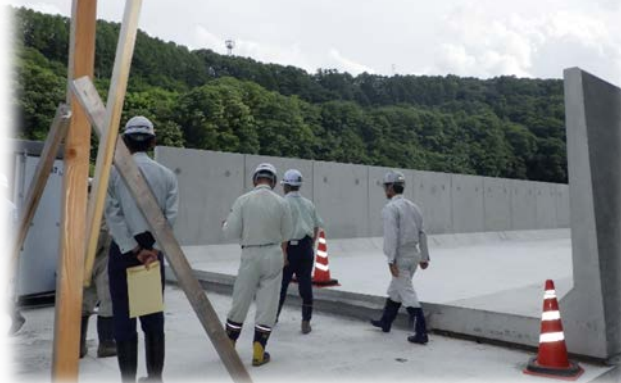
貯砂ダムから伸ばしている水路の工事現場
