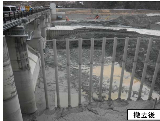
分派堰の流木(土砂含む)除去
