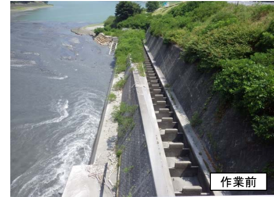
分派堰の魚道に堆積した 流木・土砂の除去および除草
