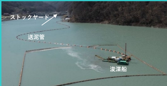
浚渫の実施状況
