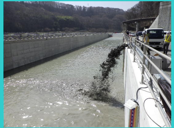
ストックヤードへの投入状況
