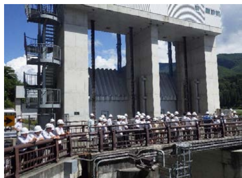
土砂バイパストンネル呑口
