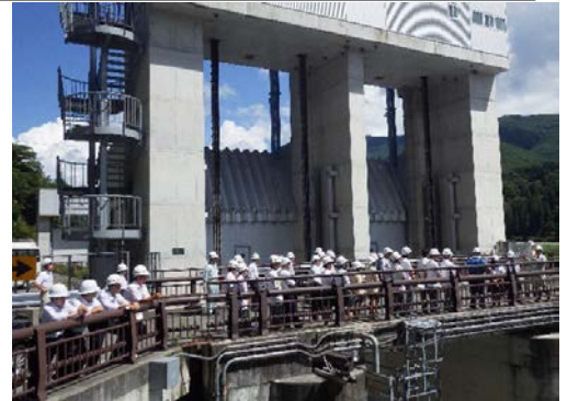
土砂バイパストンネル呑口
