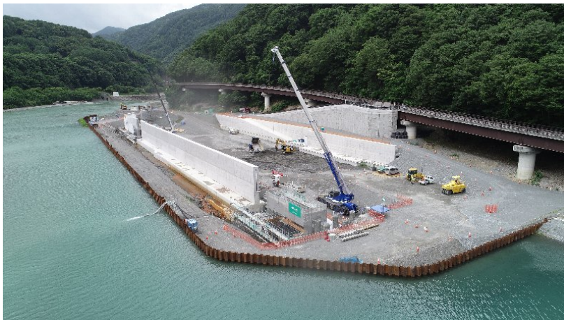
ストックヤード工事現場
