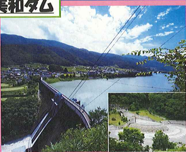
美和発電所とバイパストンネル施設も見学
