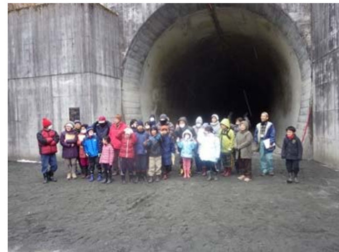
土砂バイパストンネル吐口
