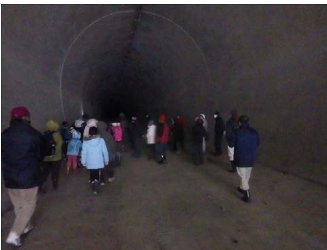
土砂バイパストンネル吐口
