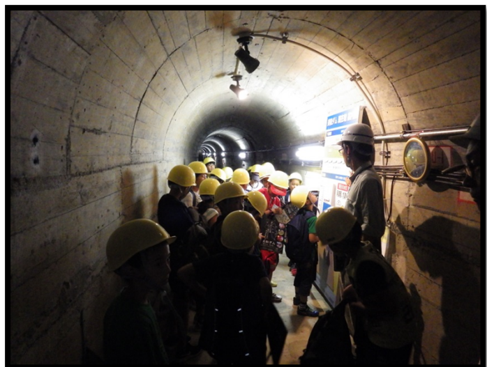
美和ダム監査廊
