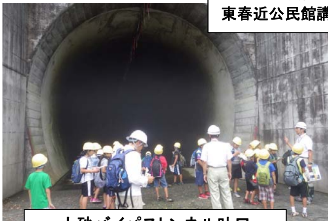
土砂バイパストネル吐口
