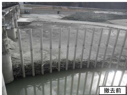
分派堰の流木(土砂含む)除去
