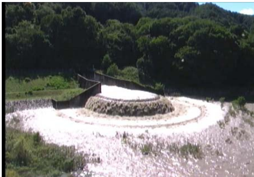
【土砂バイパストンネル吐口】②
