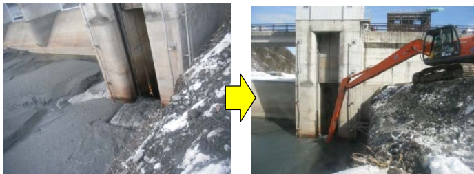
分派堰右岸ゲート付近に 堆積した土砂の除去
