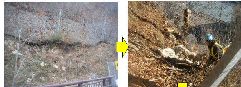
分派堰左岸の管理用通路の 防護ネットに堆積した落石の除去
