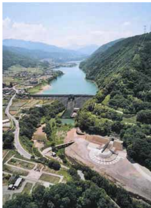
美和ダムと三峰川バイパス吐口
