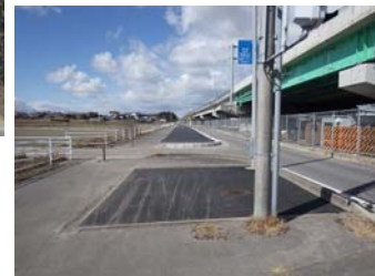
中原地区 終点から起点を望む 完了しました。
