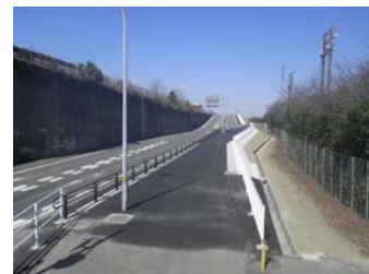
藤井地区 藤井ICから起点を望む 完了しました。
