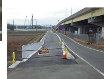
中原IC周辺 終点から起点を望む (上り線側)
