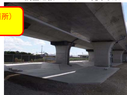
調整池張コンクリート完了状況
