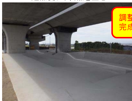
起点側より終点を望む
