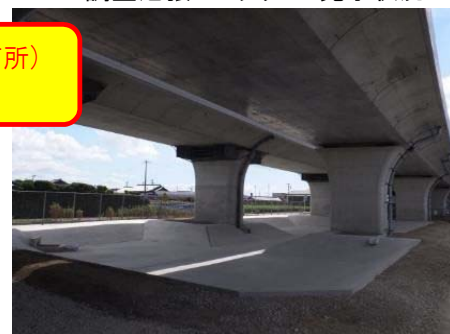
調整池張コンクリート完了状況
