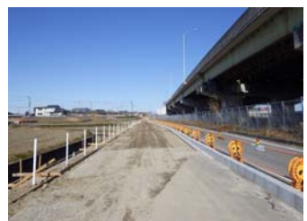
中原IC周辺 終点から起点を望む (下り線側)
