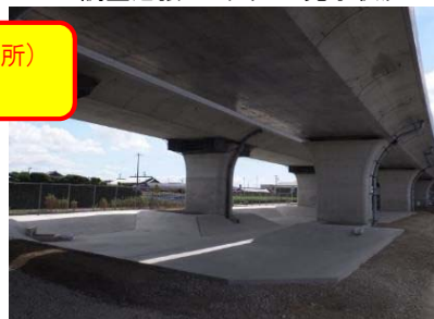
調整池張りコンクリート完了状況
