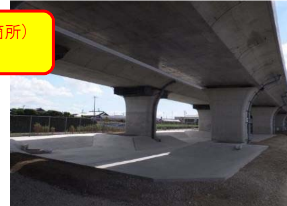
調整池張コンクリート完了状況
