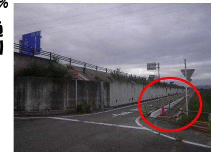
起点から藤井ICを望む 9月21日より側道通行止にて歩車道境界ブロック施工中
