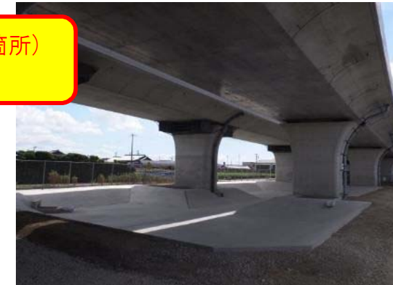
調整池張コンクリート完了状況
