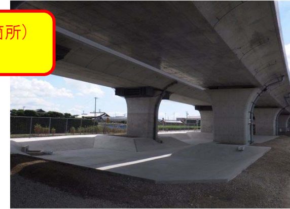
調整池張コンクリート完了状況
