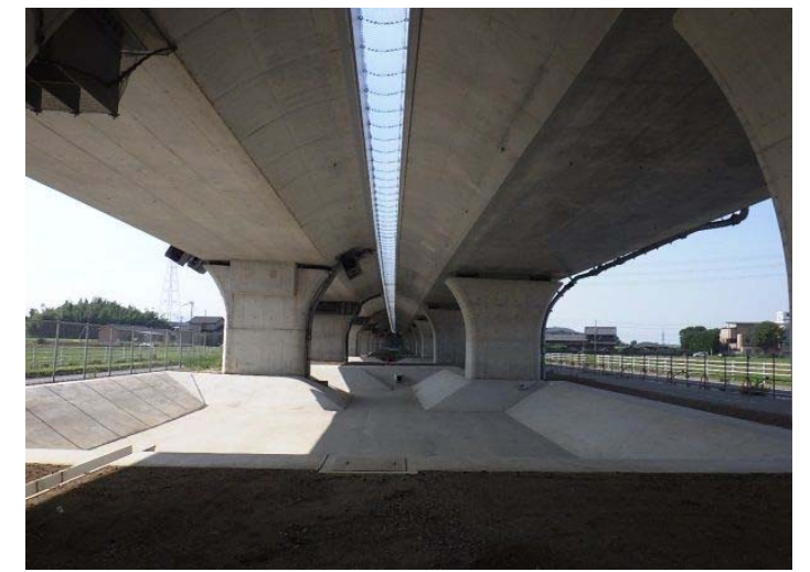
調整池張りコンクリート完了状況
