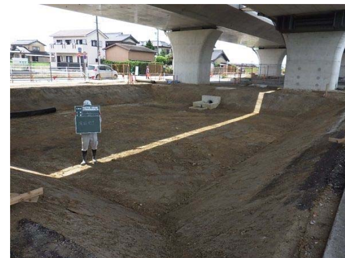
調整池掘削完了状況
