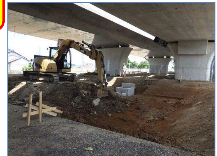
調整池掘削状況
