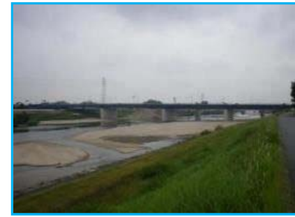
左岸下流側より望む
