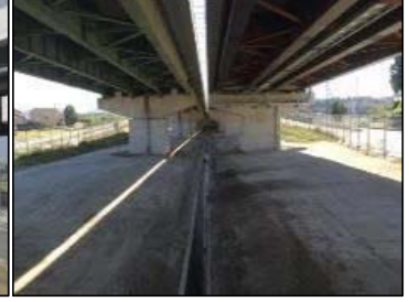
豊橋方面を望む (高架下)
