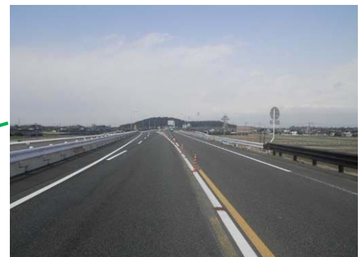
4車線開通 西尾東工区 全景
