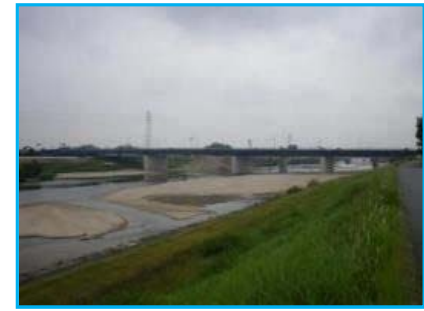
左岸下流側より望む
