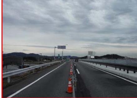
新矢作川橋～豊橋側を望む
