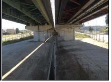
豊橋方面を望む（高架下）
