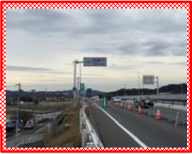
上10 西尾市標識設置完了
