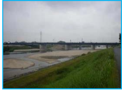
左岸下流側より望む
