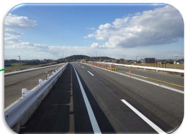
下り線開通 西尾東工区 全景
