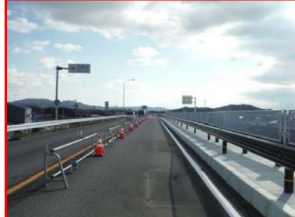
新矢作川橋～豊橋側を望む
