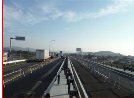
新矢作川橋～豊橋側を望む
