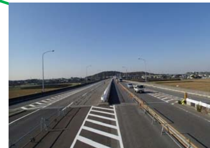
西尾東工区 全景
