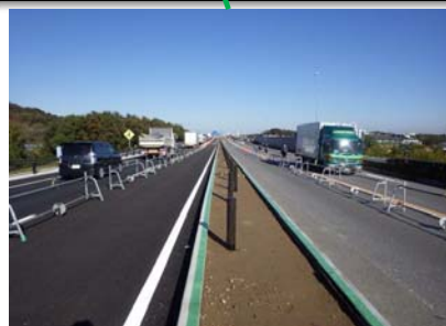
小島工区 ガードレール施工中
