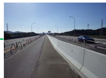
中原工区 7'レール防護柵完了
