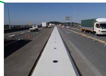
西尾東工区 ガードレール基礎施工中
