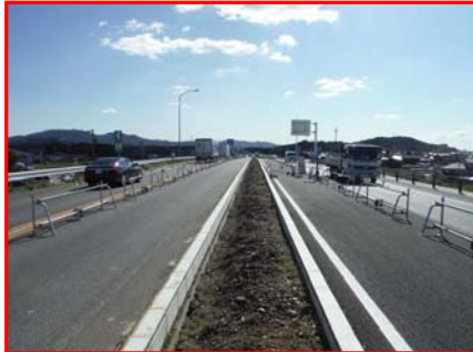
新矢作川橋～豊橋側を望む
