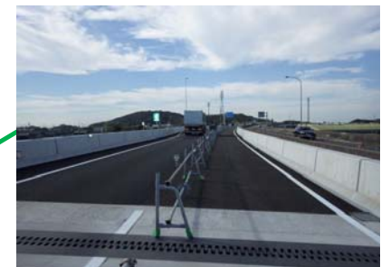
安藤岡島高架橋 セパレート完了
