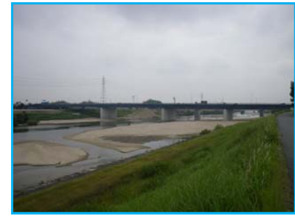
左岸下流側より望む
