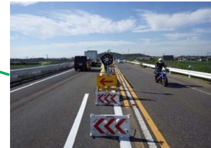
西尾東 セパレート完了
