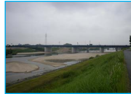
左岸下流側より望む
