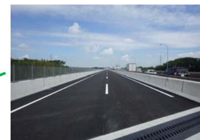
矢作古川橋 排水性舗装完了
