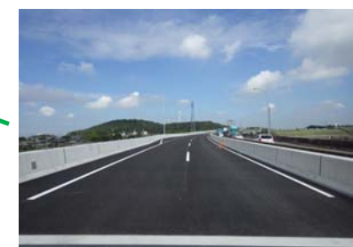
安藤岡島橋 排水性舗装完了
