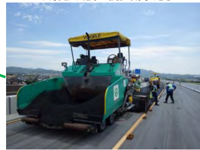
安藤岡島橋 舗装状況
