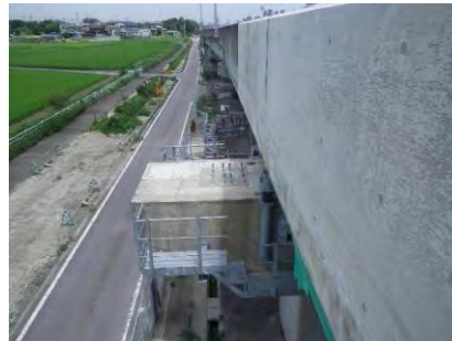
標識アンカー設置完了(下り線 矢作古川橋北側)
