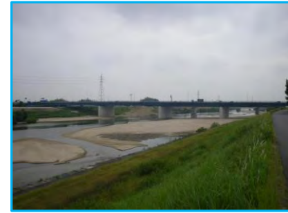
左岸下流側より望む
