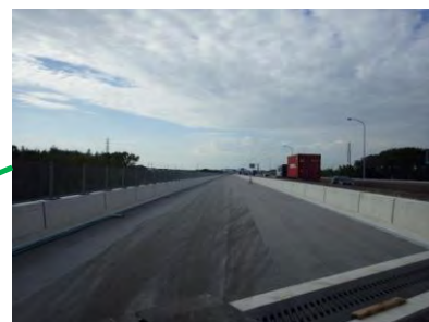
矢作古川橋 橋面防水完了
