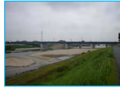
左岸下流側より 鋼橋架設作業完了
