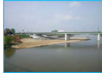
左岸上流側より 工事用道路撤去中
