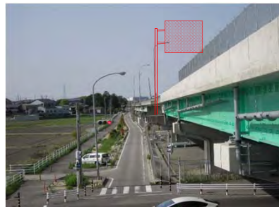
下り線 矢作古川橋から北を望む 施工
