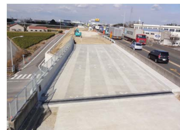
工事完成写真
