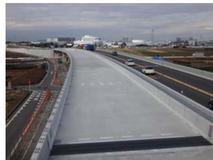
橋梁工事完了
