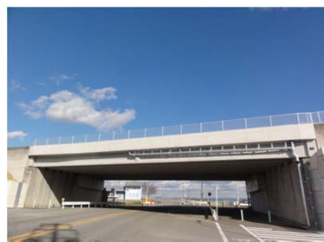
工事完成写真
