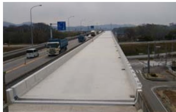
床版工(名古屋方面から撮影)
