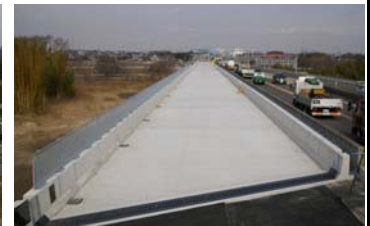
床版工(豊橋方面から撮影)
