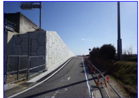
盛土・補強土壁 完了
