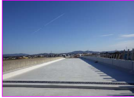
岡西跨道橋 床版・壁高欄施工中
