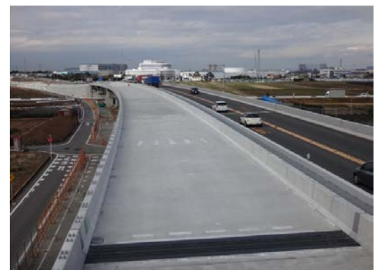
橋梁工事完了
