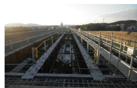
架設状況: 藤井IC側より豊橋方面を望む
