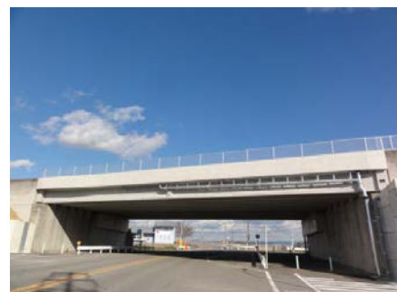
工事完成写真
