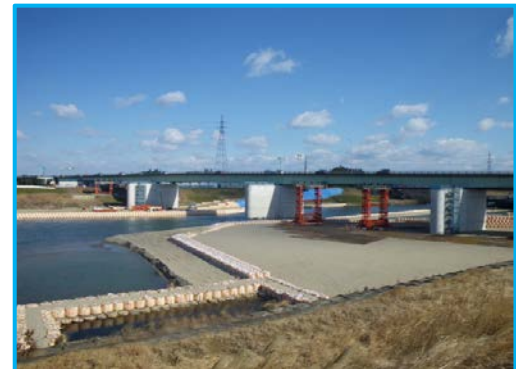
左岸下流側より バント組立作業中
