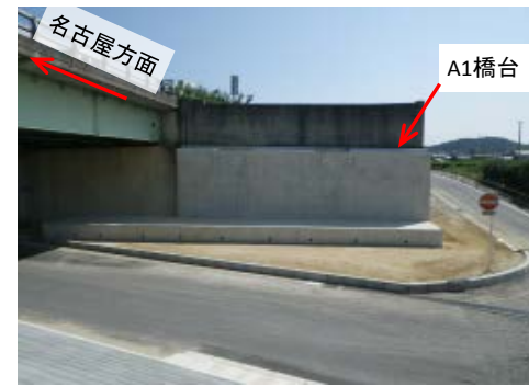
A1橋台施工完了
