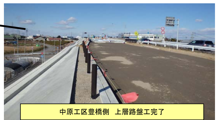
中原工区名古屋側 法面モルタル吹付け完了
