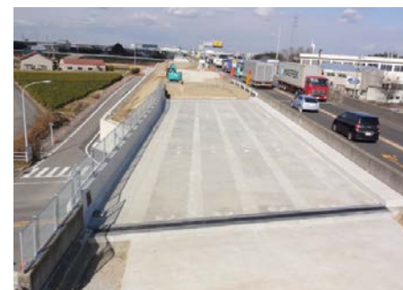
工事完成写真
