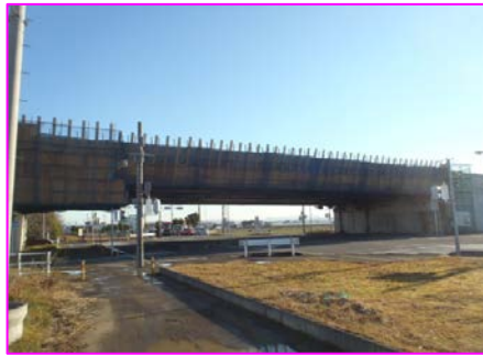
岡西跨道橋 足場解体予定
