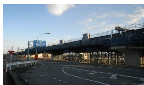
架設状況: 鋼4径間連続非合成鋼桁
