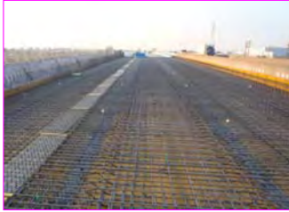
岡西跨道橋 床版鉄筋組立完
