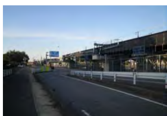
架設状況: 鋼4径間連続非合成鉄桁
