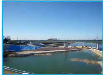
左岸上流側より 作業ヤード造成完了
