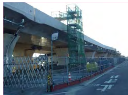
施工状況 PD7側から望む
