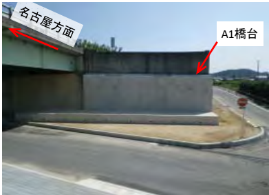
A1橋台施工完了
