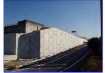
盛土・補強土壁 完了
