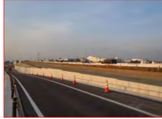
擁壁・盛土 完了
