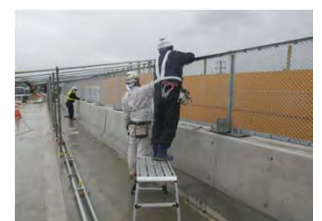
落下物防止柵設置状況
