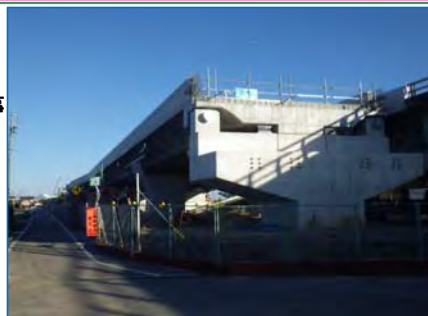
施工状況 PDA側から望む
