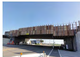
足場設置状況
