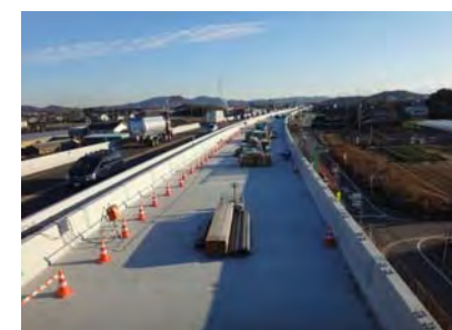
地覆壁高欄施工状況
