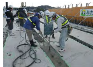
床版コンクリート打設状況
