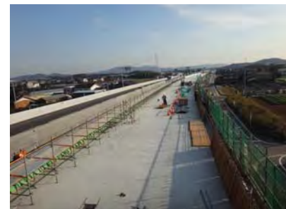
地覆壁高欄施工状況
