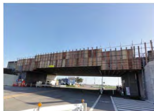
足場設置状況
