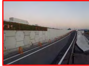
盛土・排水構造物施工中
