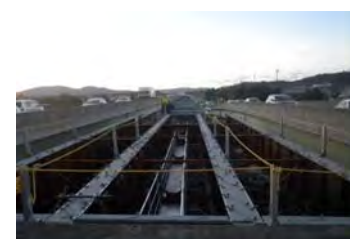
架設状況:藤井IC側より豊橋方面を望む
