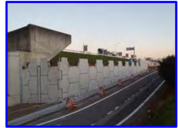
盛土・補強土壁施工中
