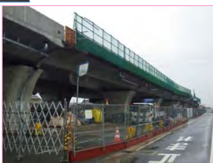
施工状況 PD7側から望む
