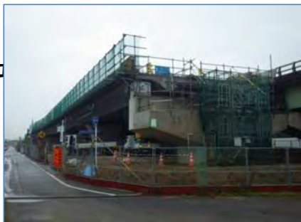
施工状況 PDA側から望む
