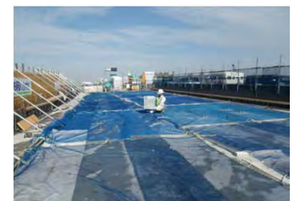
コンクリート養生状況
