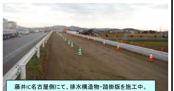
小島江原IC下りオンランプ 走行車線の切替が完了しました。
