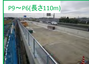
床版工事【県道479号線上】 足場を解体します。
