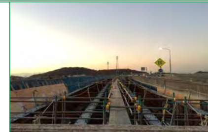
施工状況 西尾東IC方より名古屋方面を望む
