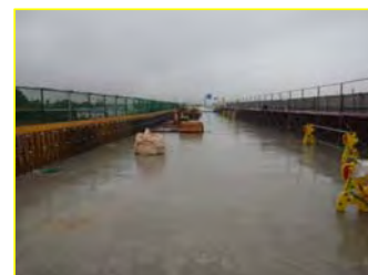
地覆壁高欄型枠施工状況
