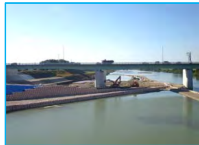
左岸上流側より 作業ヤード造成中
