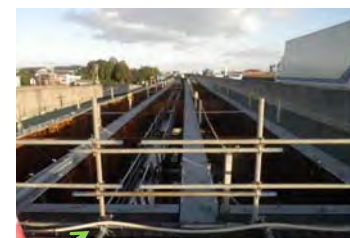
架設状況 小島IC側より名古屋方面を望む
