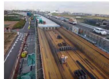
PD16-PD14主桁鉄筋・型枠組立状況
