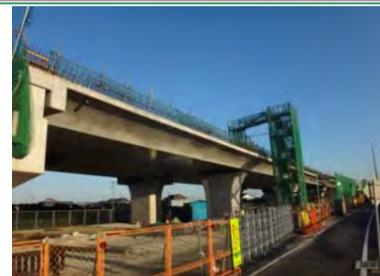
PDA-PD16主桁完了
