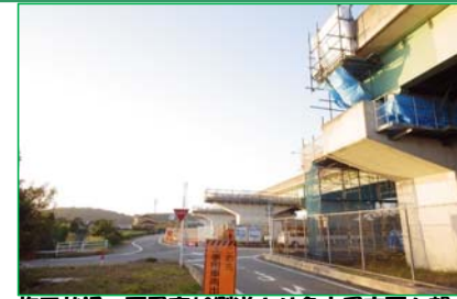
施工状況 西尾東IC側道より名古屋方面を望む
