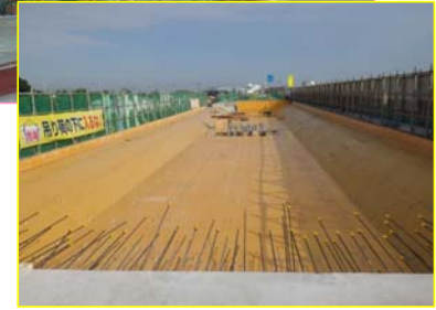
第4次施工型枠組立中
