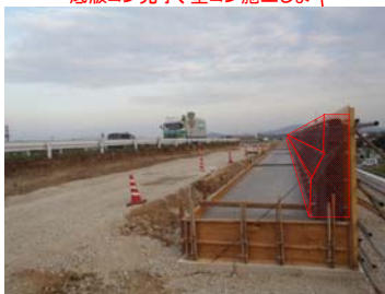
剛性防護柵基礎 底版コンクリート完了、壁コン施工します
