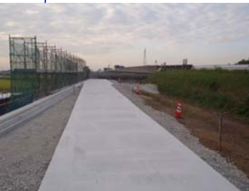
剛性防護柵基礎 施工します
