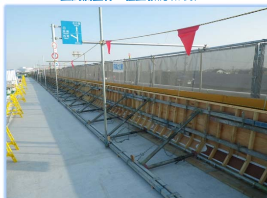
壁高欄型枠 組立状況(9/30)
