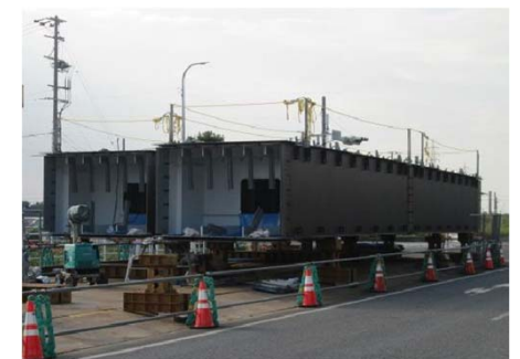
鋼桁地組立中
