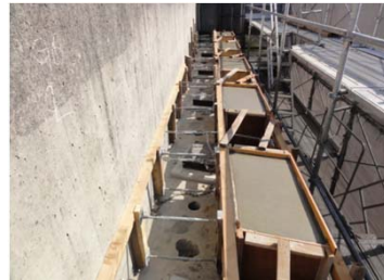
落橋防止装置壁打設完了
