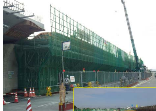
第4次施工支保工組立完了
