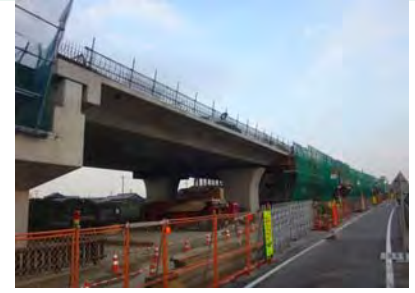
PDA-PD20主桁完了
