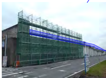
既設補強土壁の上に 天端コンクリートを施工中
