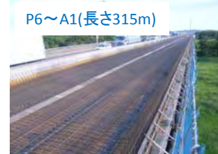
床版工事【矢作古川上】 鉄筋を組立っています。
