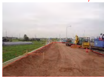
藤井インター下り線オフランプの 排水構造物、踏掛版、照明を施工
