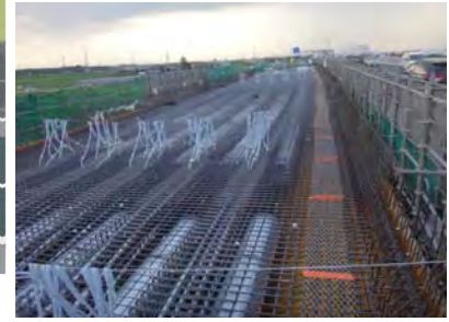
PD20-PD18主桁鉄筋・型枠組立状況
