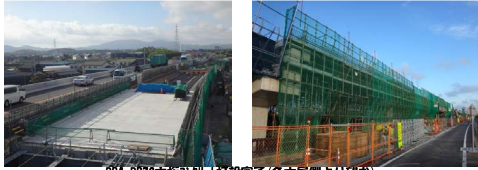
PDA-PD20主桁コンクリート打設完了(名古屋側より望む)
