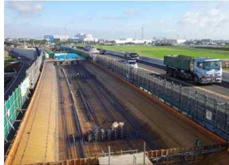
PD20-PD18主桁鉄筋型枠組立状況 (豊橋側より望む)
