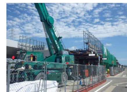
施工状況 第3次施工支保工組立中
