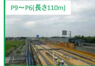
床版工事【県道479号線上】鉄筋組立中です。
