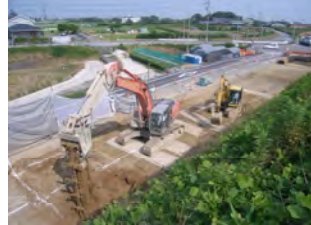
擁壁工事【志貴野町・中原町】地盤改良の状況です。
