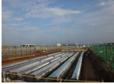
PDA-PD20主桁円筒型枠設置状況
