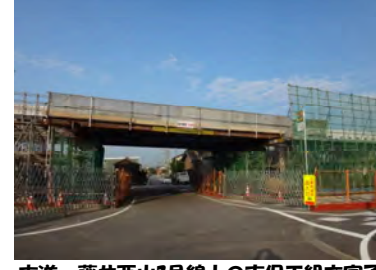
市道 藤井西山3号線上の支保工組立完了
