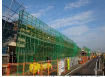
PDA-PD20主桁型枠、支保工組立完了
